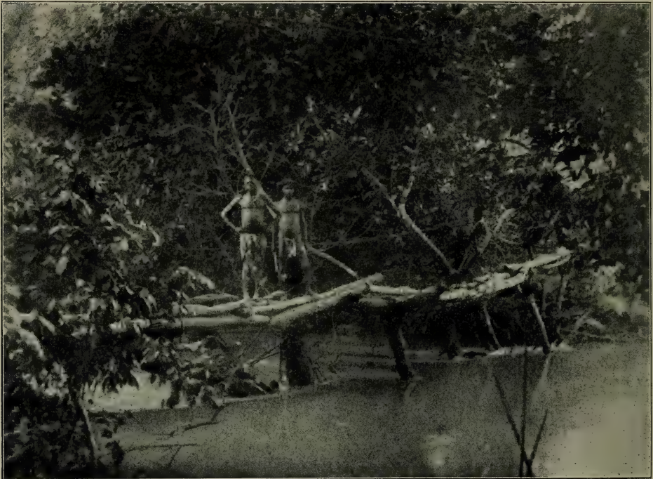
Eine Landesbrücke über einen angeschwollenen Fluß.
